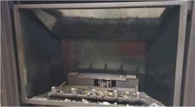
Schéma 7 - Installation complète des panneaux
